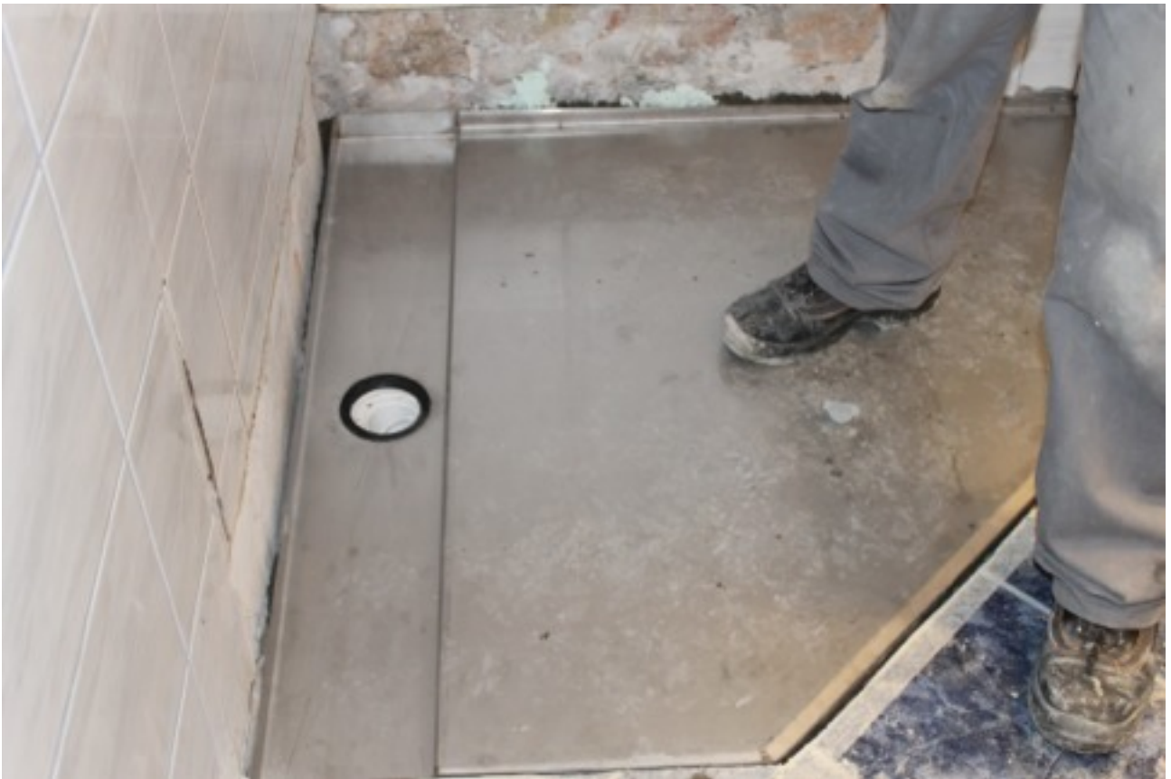
Wanne einlegen, ausrichten und festtreten
