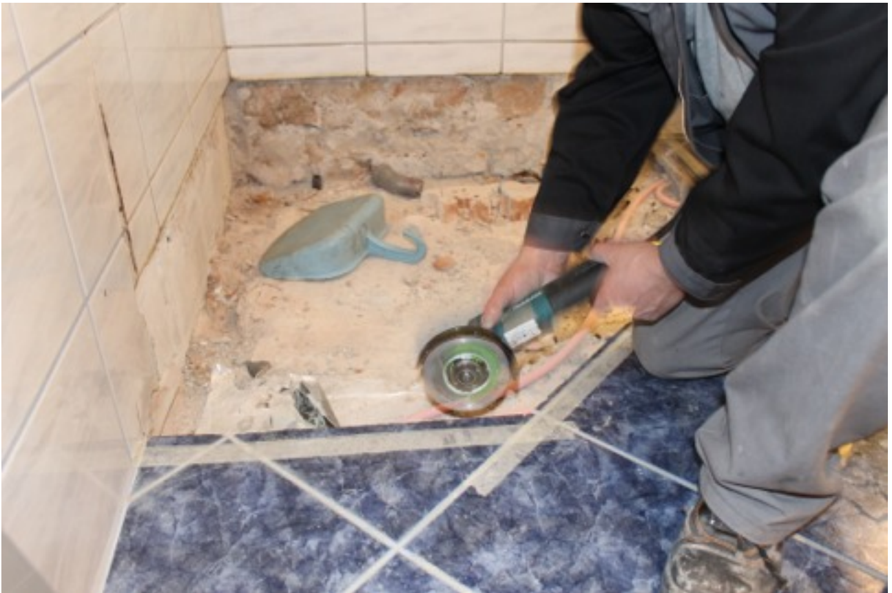
Fliesenkanten feinschneiden
