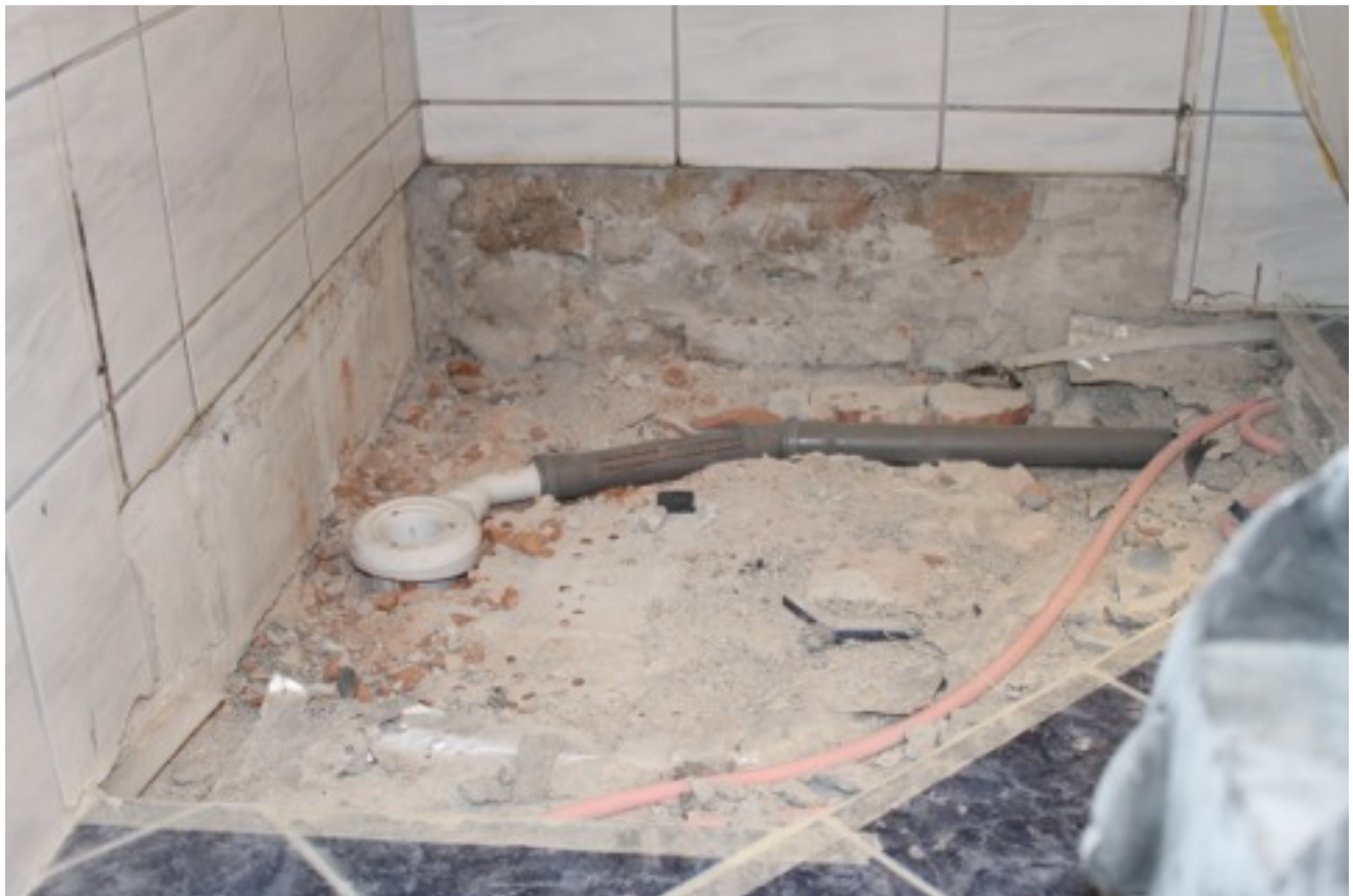
Abfluss installieren
