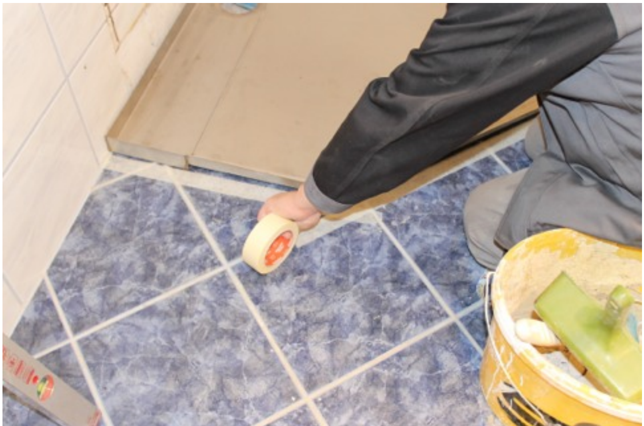
Schnittkanten mit Klebeband abkleben
