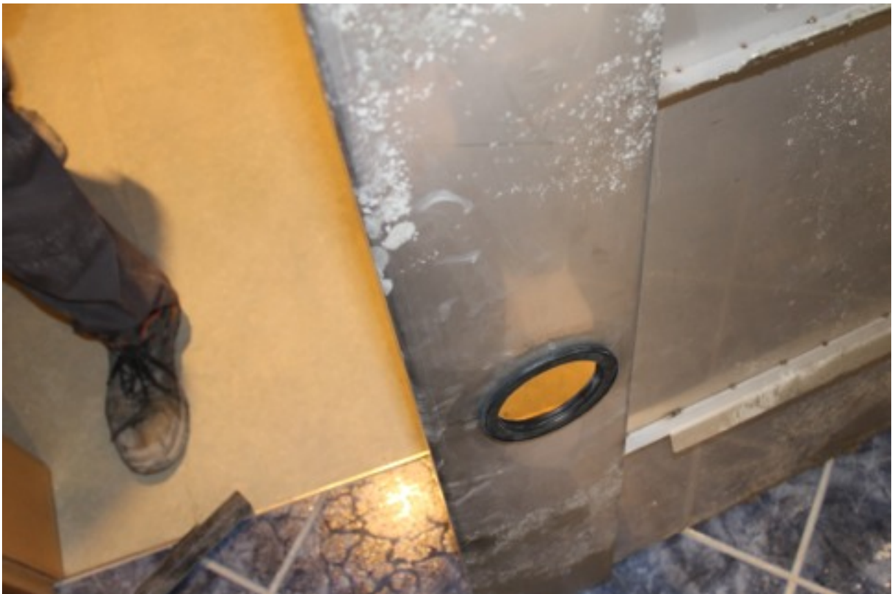
Wanne herausnehmen und Gummidichtring einsetzen
