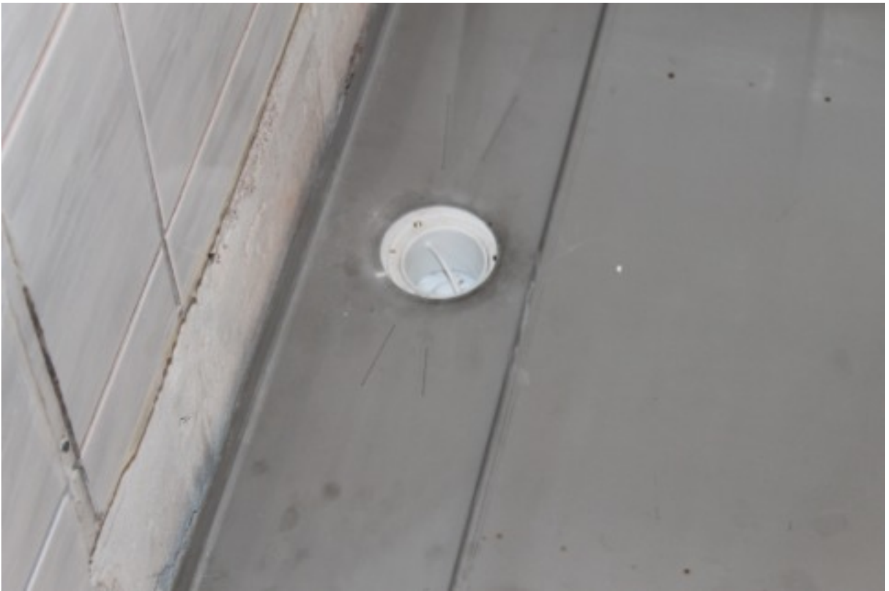
Wanne einlegen und mit Abflussposition abgleichen
