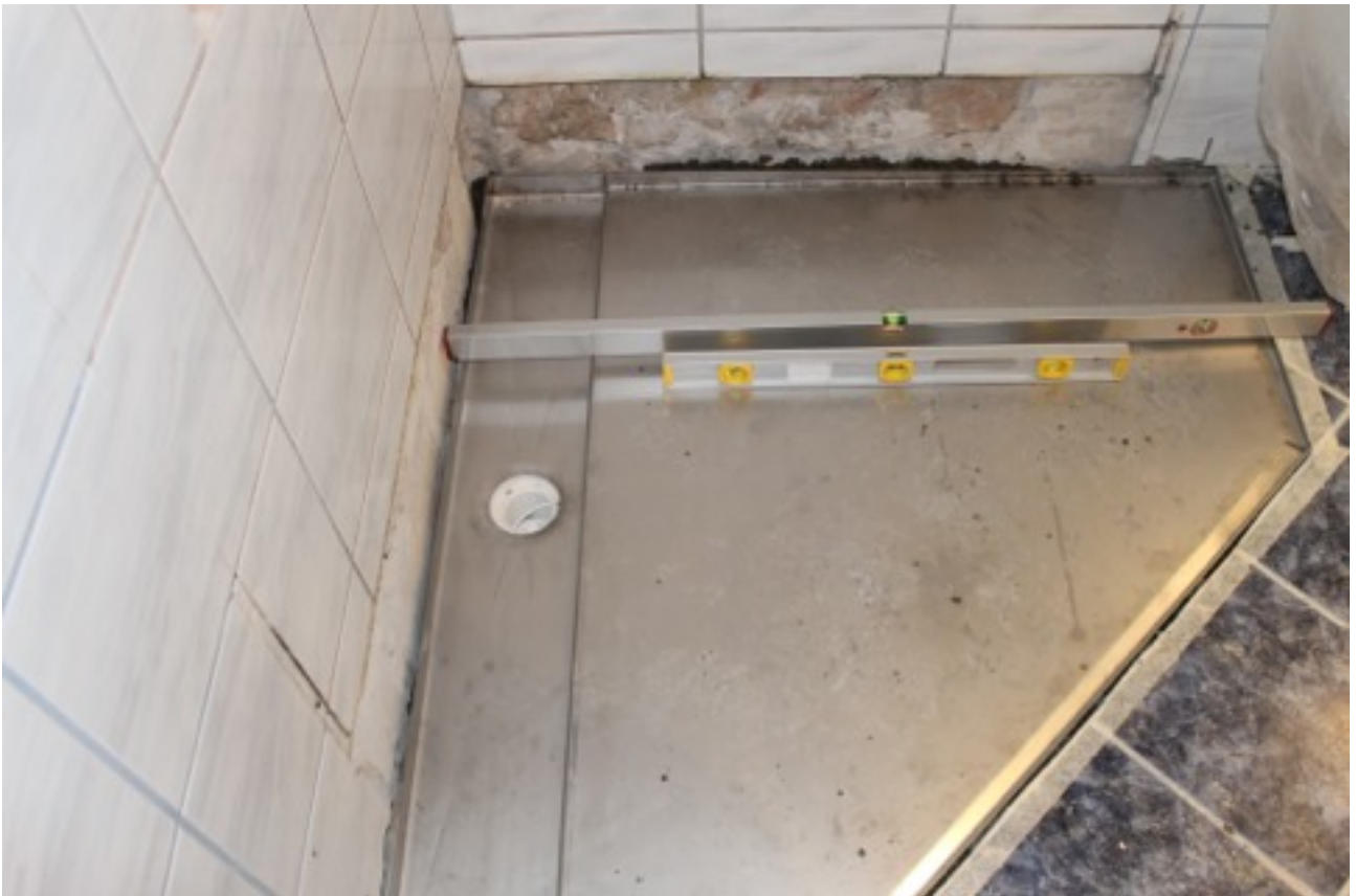
Wanne einlegen und mit Füßen festtreten um den Mörtel bestmöglich zu verteilen
