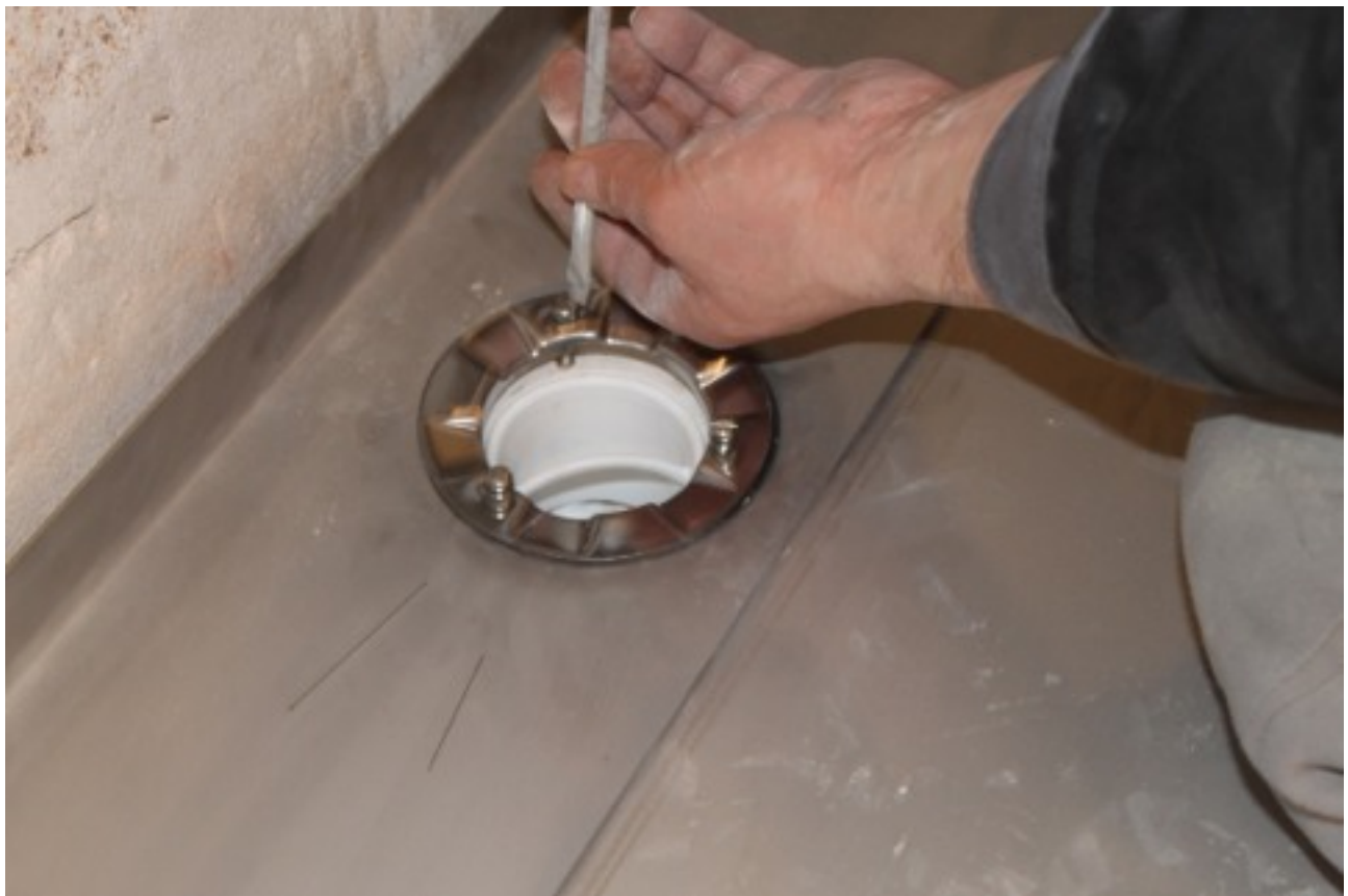
abschließend die Abflussrosette anbringen
