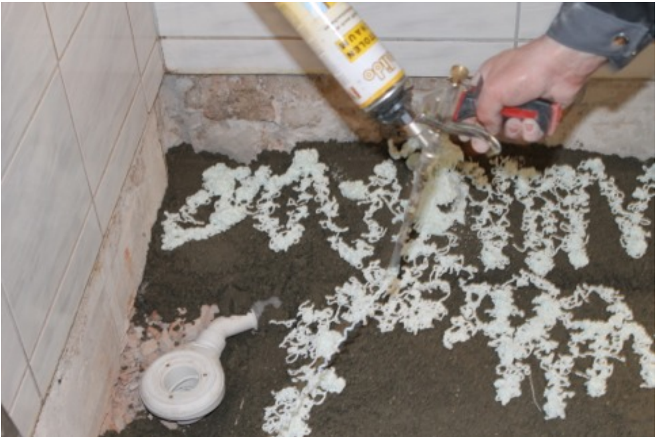
PU-Bauschaum für Trittschalldämmung und satte Auflage auftragen
