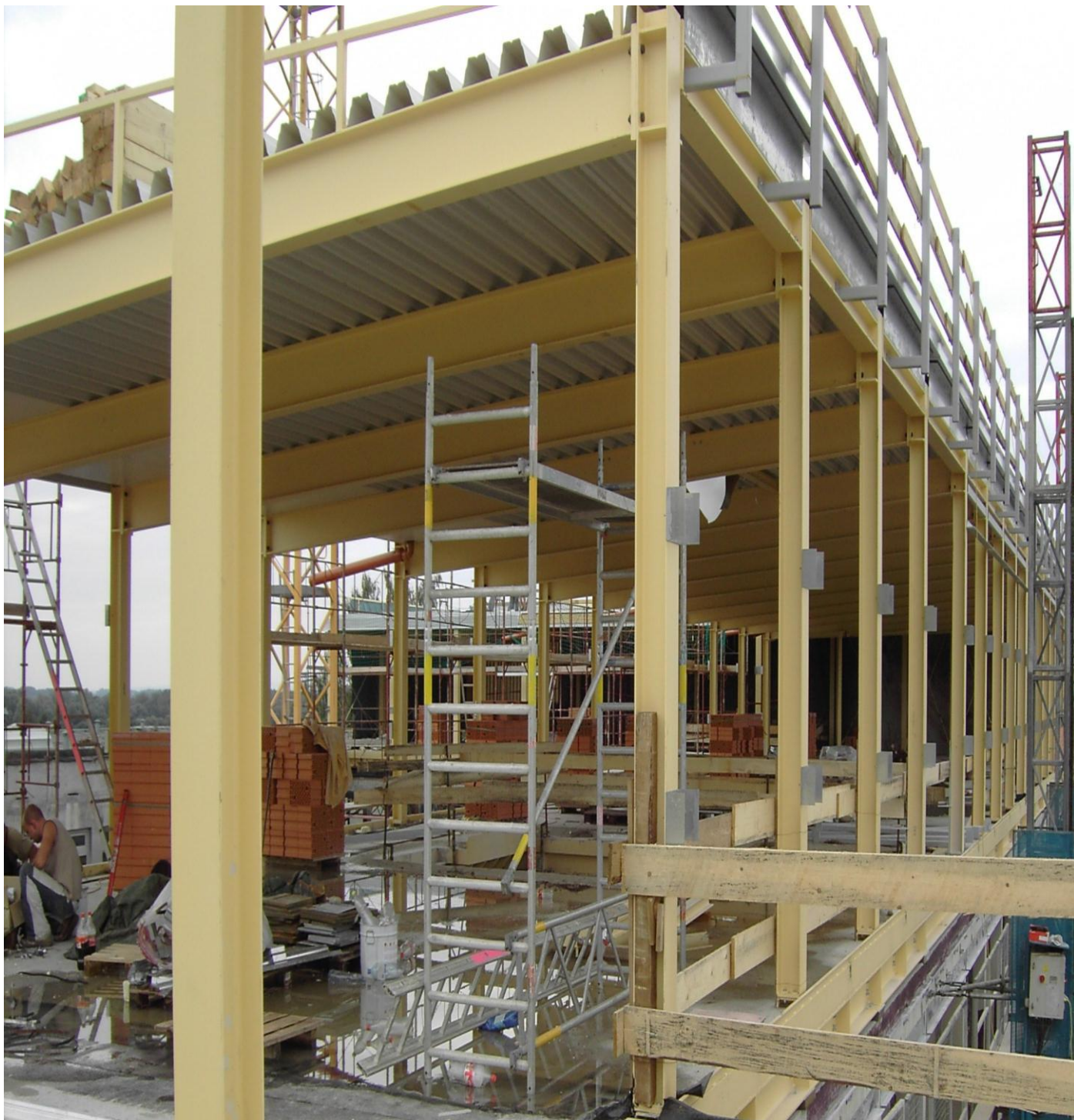
Aufbau Schule in Schärding im Innkreis. 140 Tonnen Stahl auf 11 Meter Höhe für eine Aufstockung einer Schule inkl. Tragschale verlegen. Zusammenarbeit mit der Firma Fill aus Ried im Innkreis.
